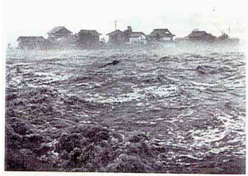
三次市、旭橋下流(寺戸)の出水状況
