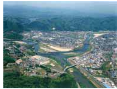
三次市三川合流部付近
