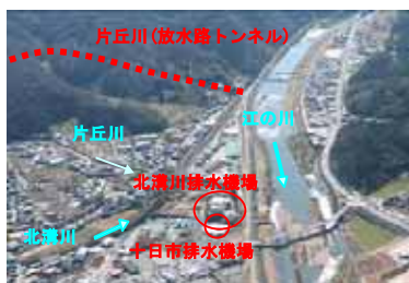
北溝川排水機場
