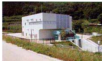
願万地排水機場
