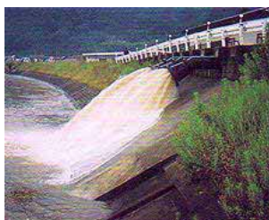
畠敷排水機場運転状況 (H10.10 出水時)
