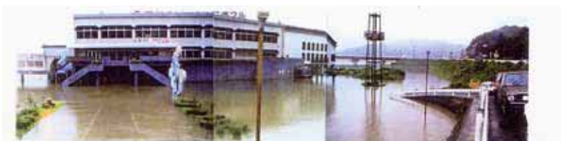
三次市寿橋付近の浸水状況
