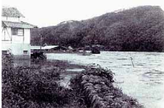
馬洗川左岸 2.2km 付近越水状況
