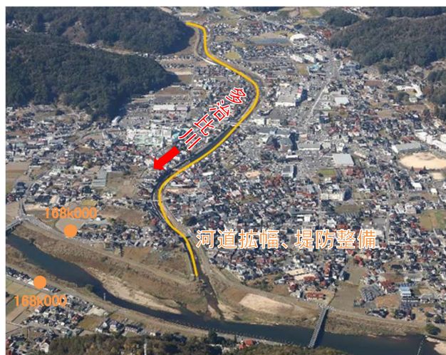
河川改修箇所(安芸高田市:多治比川)
