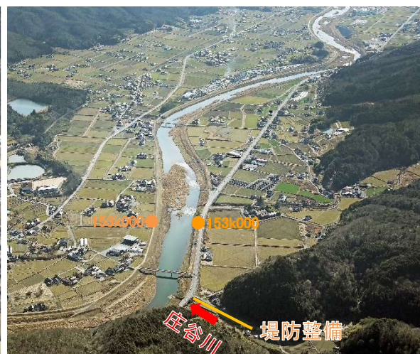
河川改修箇所(安芸高田市:庄谷川)
