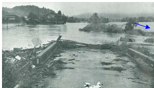
昭和47年7月浸水状況 (安芸高田市瀬戸地区)
