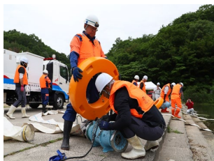
三次市における排水ポンプ車合同訓練の取組
