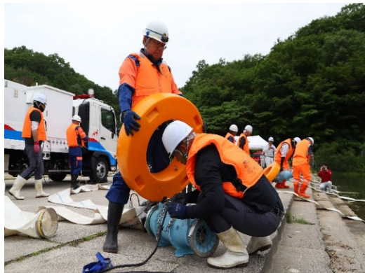
排水ポンプ車合同訓練
