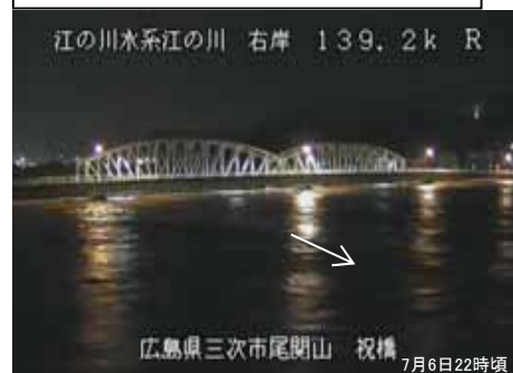
洪水の状況(尾関山水位観測所付近)
