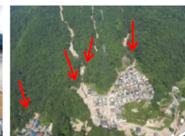
土砂災害（土砂・洪水氾濫）の状況 ひろしま (広島県広島市)
