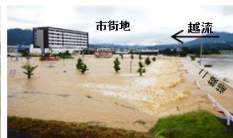
ひじ 肱川の氾濫状況 おおず (愛媛県大洲市)
