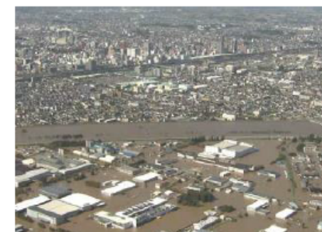
あぶくま 阿武隈川の氾濫状況 こおりやま (福島県郡山市)
