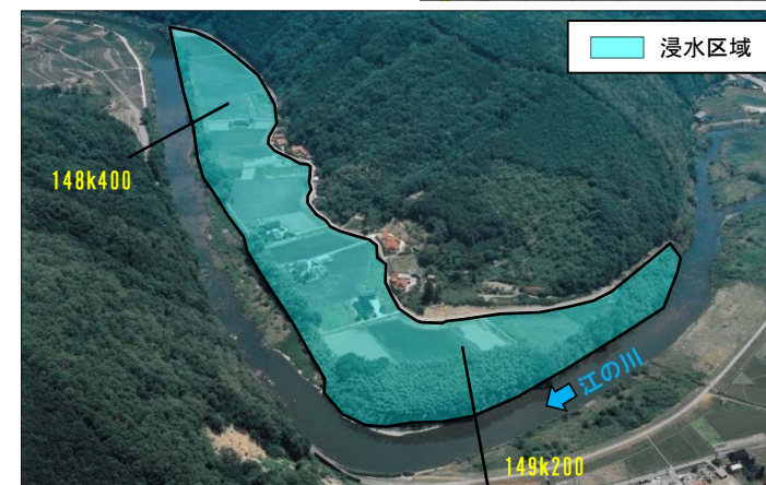
■近年の洪水による浸水被害
