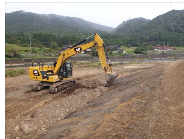
マシンガイダンスによる掘削作業（柳原地区）
