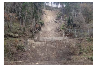
施工前〔山腹工〕
