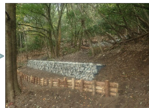
施工後(筋工)
