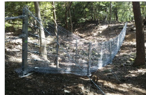
施工後(落石防護柵)
