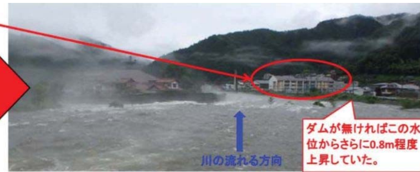
今回の加計中学校付近河川状況(水位3.14m)
