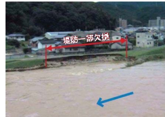
平成30年7月豪雨の被災状況 (三篠川右岸4k200付近)
