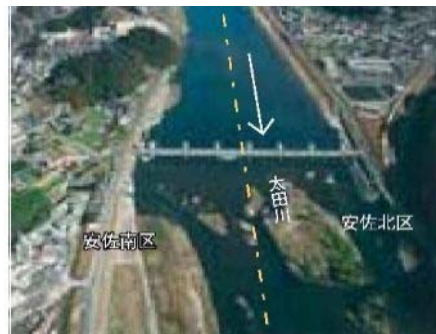
4) 高瀬堰(昭和50年完成)
