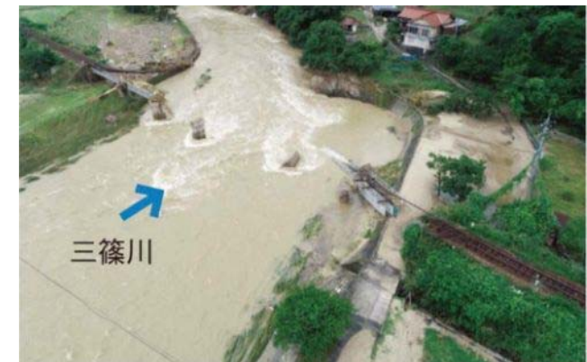
平成30年7月豪雨によるJR橋梁流失状況 (広島市安佐北区白木町三口)
