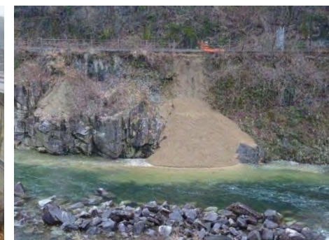
置砂:ダム直下 (平成28年2月24日、3月9日実施)
