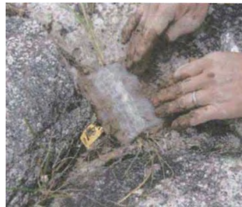
■シモツケ種子の植え付け施工状況
