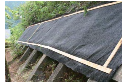
イタチハギ繁殖防除のための 遮光ネット設置状況
