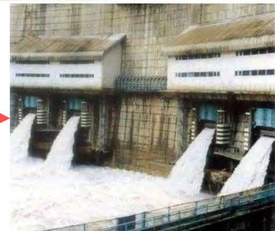
常用洪水吐(コンジットゲート)
