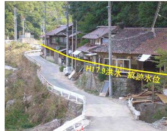
平成17年9月洪水の被害状況 (被災痕跡水位) (広島市安佐北区安佐町大字久地地先)
