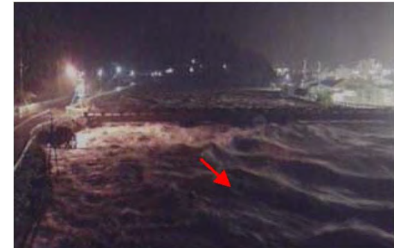
平成17年9月洪水の様子 (太田川61.7k 堂見橋下流右岸)
