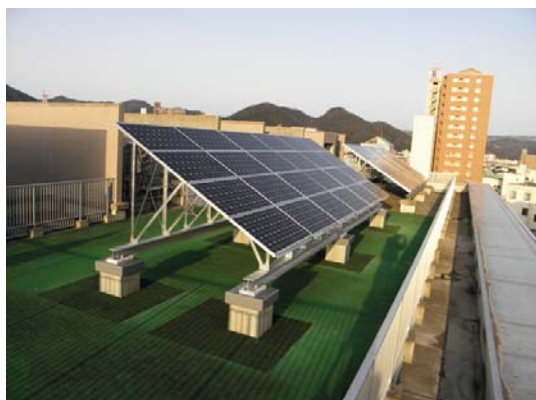
太陽光発電設備の設置 (鳥取労働局)
