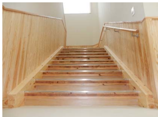
木造化による内部階段 (境海上保安部竹内船艇用品庫)
