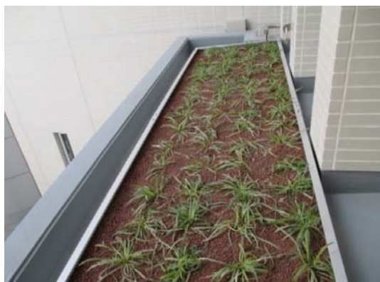
屋上緑化の整備 (岡山法務総合庁舎)
