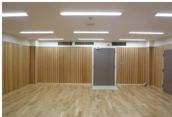
木質化による内装改修 (鳥取第3地方合同庁舎)
