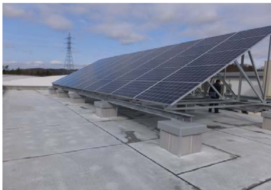
太陽光発電設備の設置 (岡山運輸支局)
