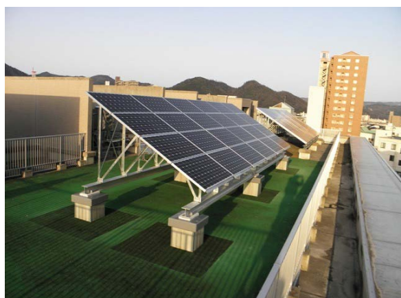
太陽光発電設備の設置 (鳥取労働局)
