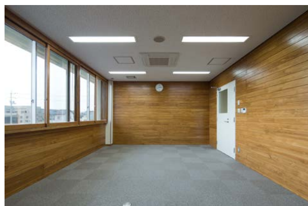
木質化による内装改修 (境税関支署)
