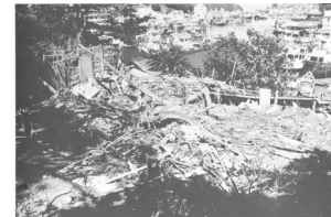
9人が生き埋めになった土砂崩れ (姫路市家島町宮)
