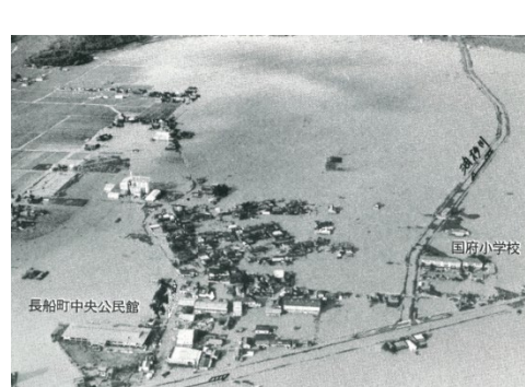
瀬戸内市長船町の浸水状況
