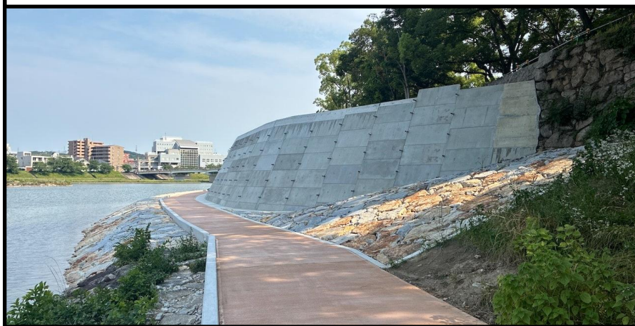
施工状況 令和8年6月
