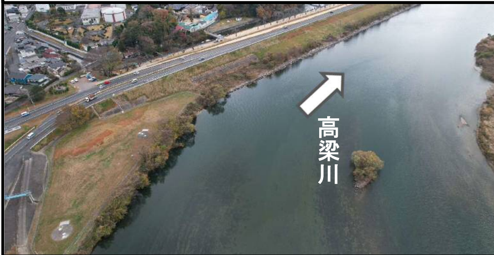
施工前 令和7年12月
