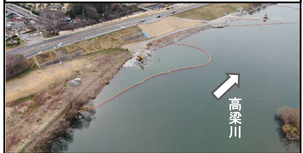
施工状況 令和8年3月
