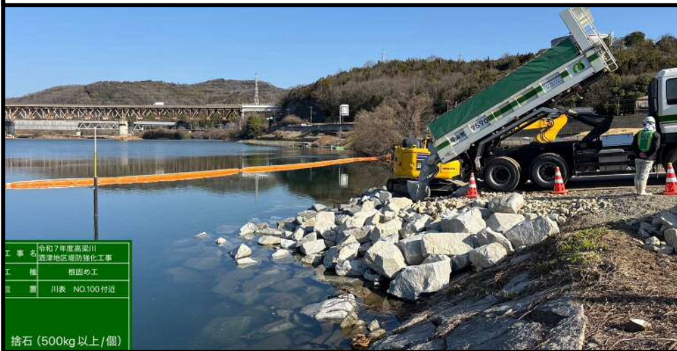
施工状況 令和8年2月
