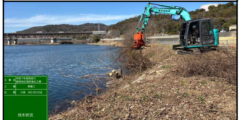
施工状況 令和8年2月
