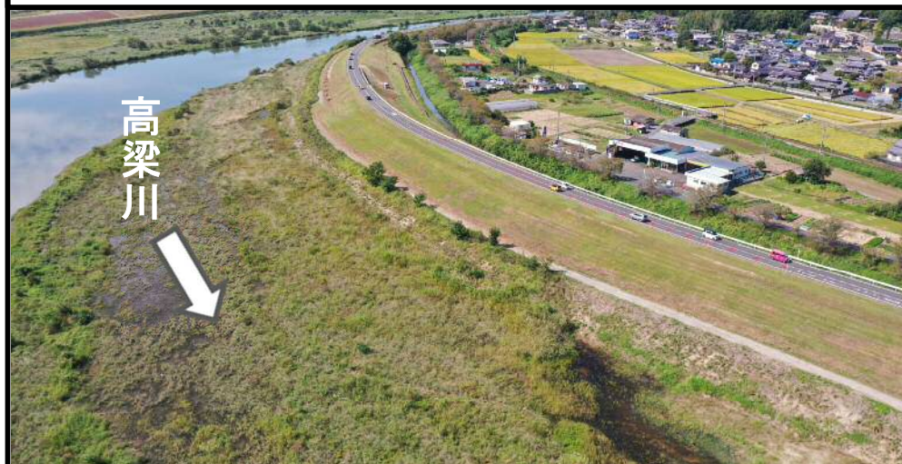
施工前 令和7年10月
