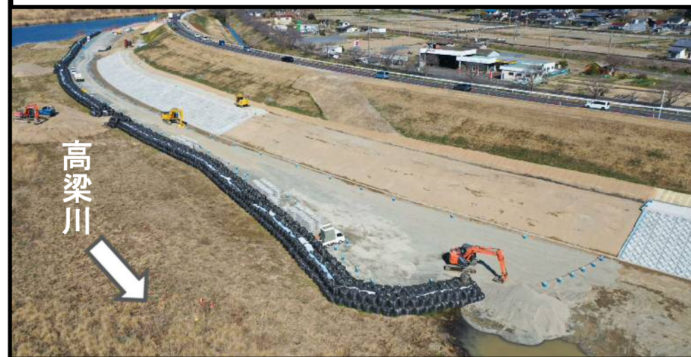
施工状況 令和8年3月
