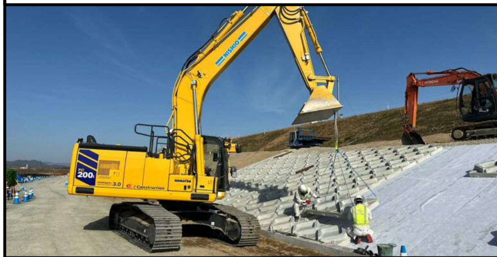
施工状況 令和8年3月
