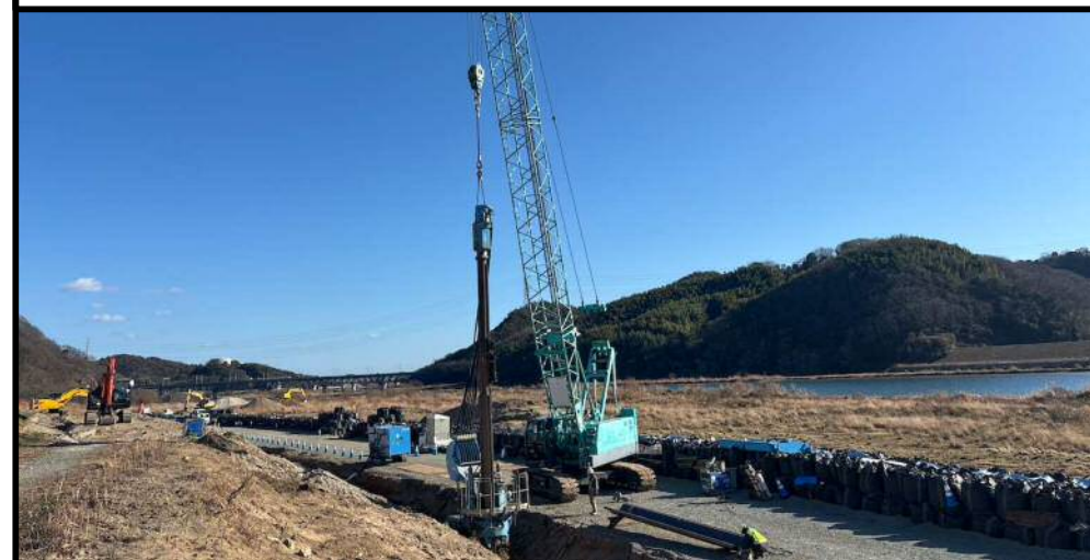
施工状況 令和8年1月
