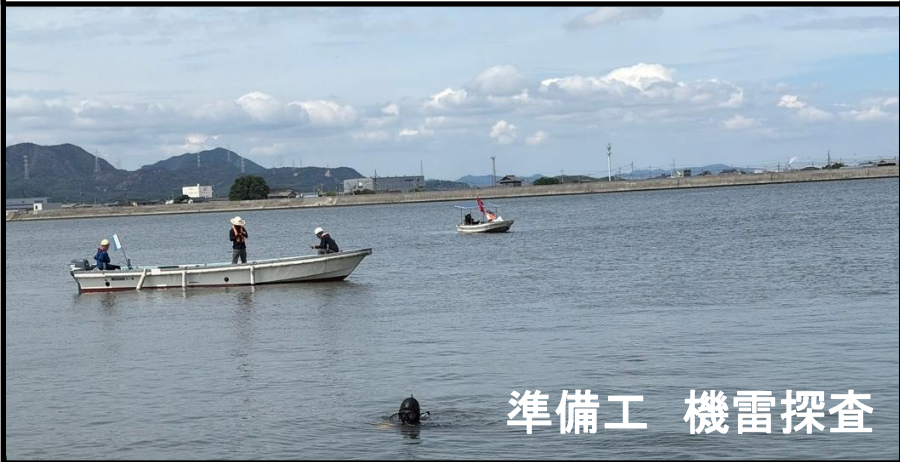
施工状況 令和8年6月
