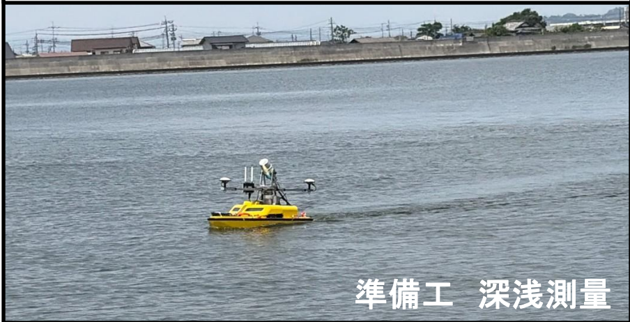
施工状況 令和8年6月
