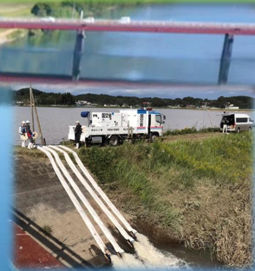
排水ポンプ車で緊急時対応
