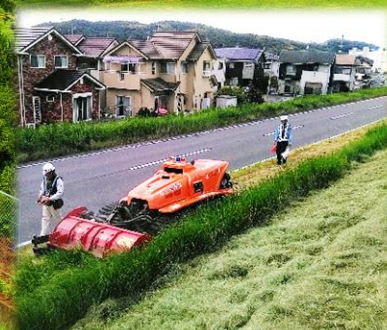
~大型遠隔操作式草刈車での作業風景~
