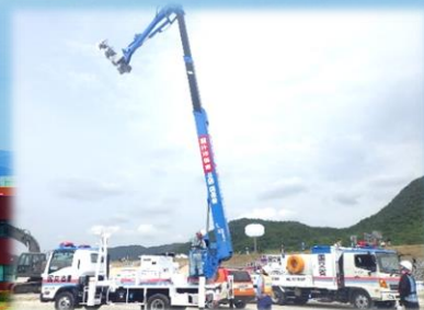
~照明車による緊急時対応~ 吉井川総合水防演習に参加
