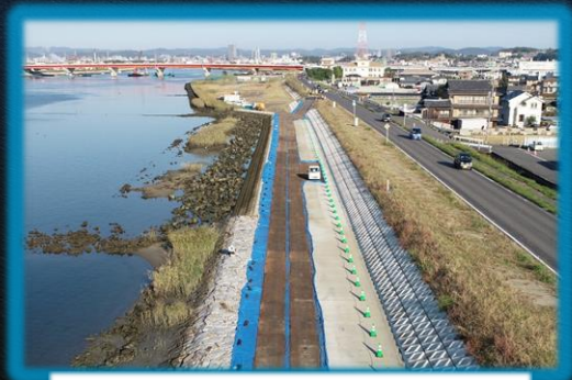
『工事用進入路に敷鉄板を敷設』
