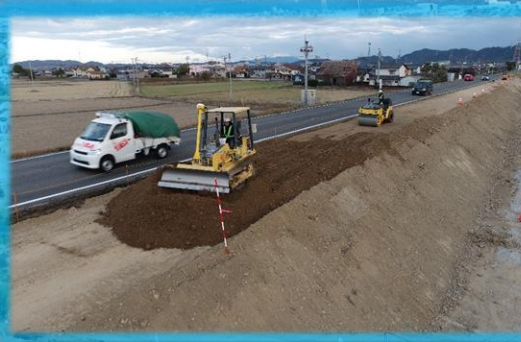
『GNSSを活用した堤防盛土の作業』
