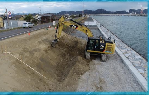
『ICT(MG)を活用した法面整形の作業』
