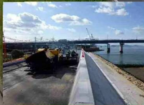
『アスファルト舗装作業』
