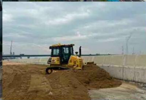
『ICTを活用した築堤盛土作業』
