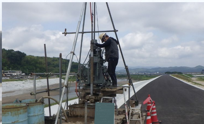
ボーリング調査
