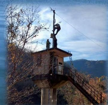
水位流量観測所への流速解析補正用風向風速計設置
