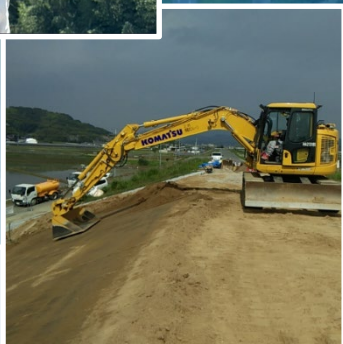
TLSによる出来形計測
