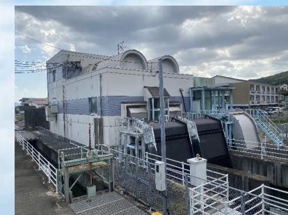
倉安川排水機場
