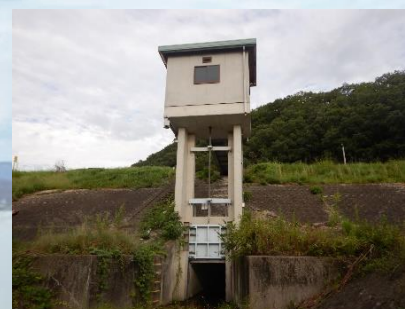
勢力第三排水樋門
