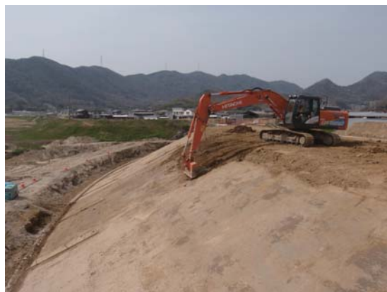
河川側法面の整形状況
