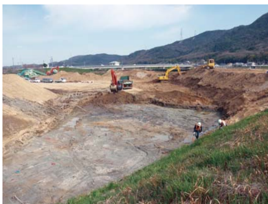
河川裏の盛土に備え地盤改良の準備状況
