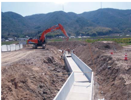
一ノ口樋門の取水路施工状況
