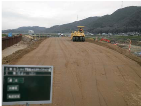
築堤盛土施工状況
