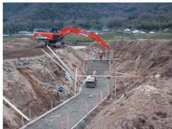
一ノ口樋門の施工状況
