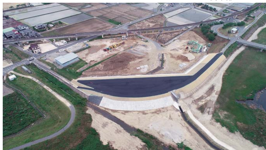
復旧完了（全景）
