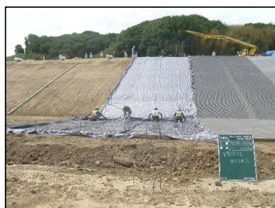
【施工状況（下流締切堤）】
