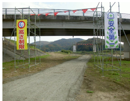
【安全施設設置状況】
