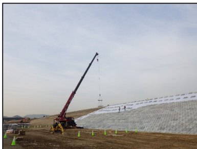
【施工状況（上流締切堤）】
