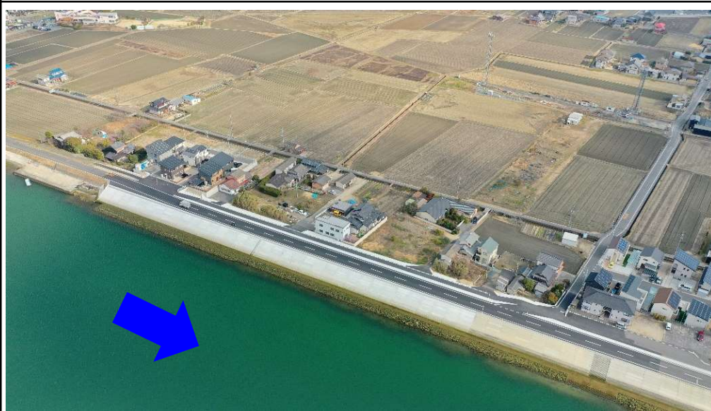
整備状況(令和3年1月完成)
