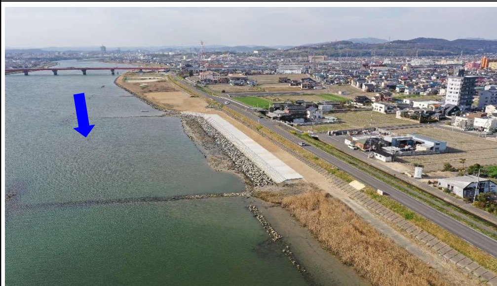
整備状況(令和3年3月完成)
