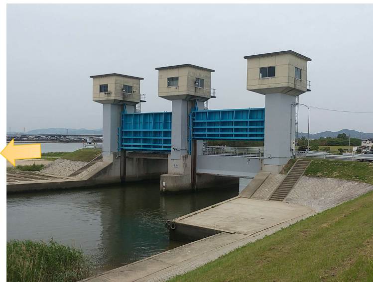
整備状況(令和3年6月完成)
