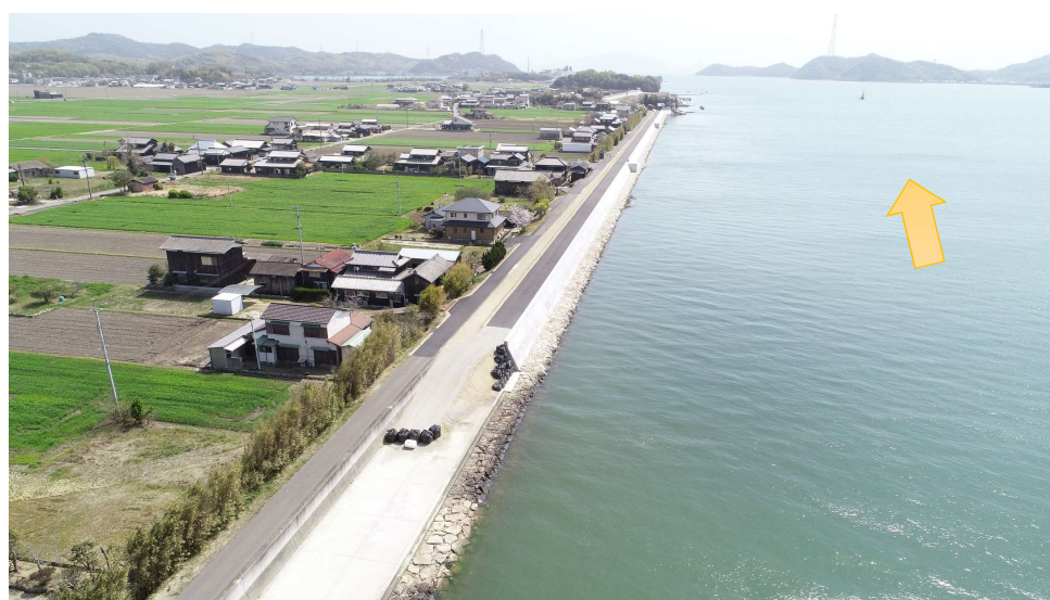
整備状況(令和3年3月完成)
