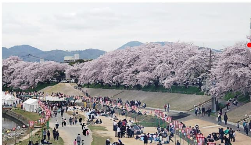
H26年度施工済区間(H27.4) スロープ設置により回遊性が向上
