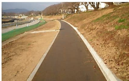
景観に配慮しカラー舗装で整備
