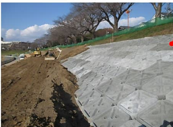
H27年度 護岸施工状況(H27.12)
