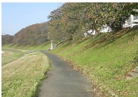
下部遊歩道整備
