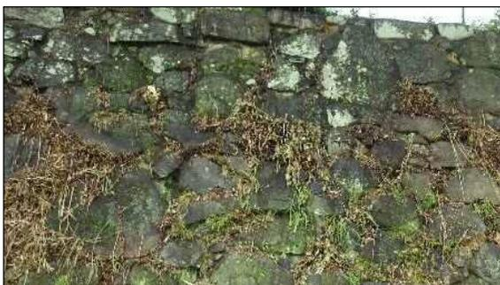
写真14【弓橋跡】野面空石積み目地モルタル
