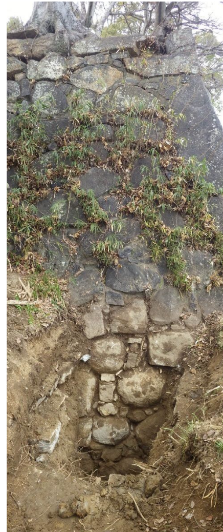
石垣全景写真
