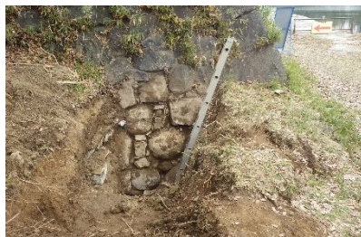
トレンチ全景写真
