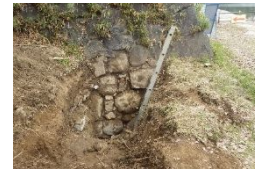
トレンチ全景写真
