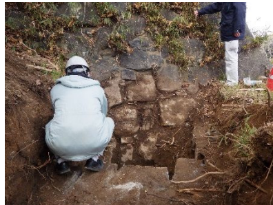
練り石張り写真
