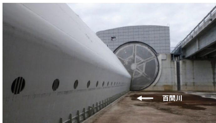
増築の新水門(ライジングセクターゲート: 仮締切中)
