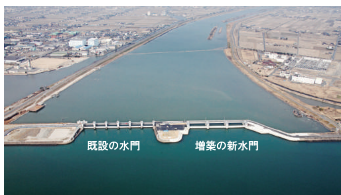
既設の水門と増築の新水門
