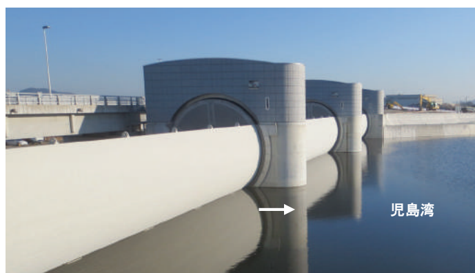
増築の新水門(児島湾側からの眺め)
