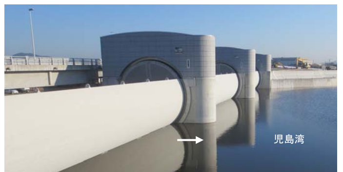
平成 water gate (児島湾側からの眺め)
