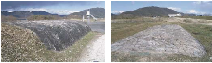
下流巻石部(亀の甲)の現状 上流巻石部(亀の甲)の現状
