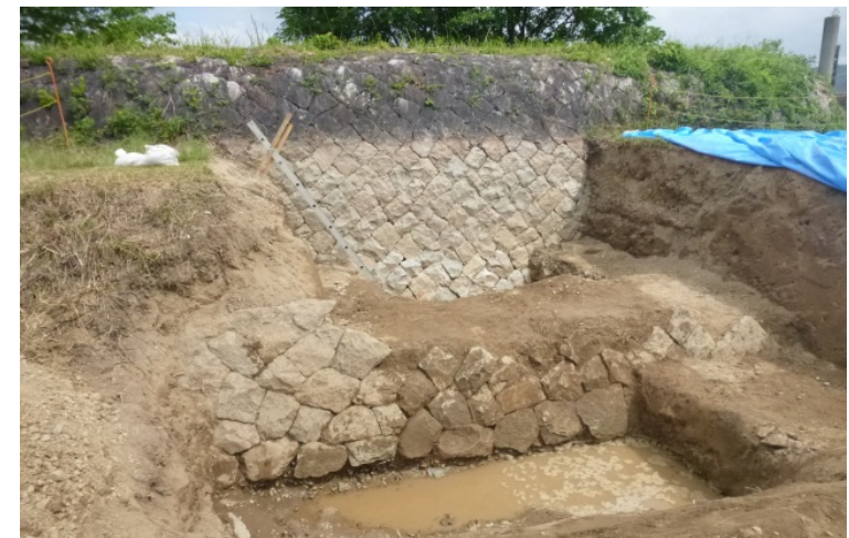
下流巻石部(亀の甲)試掘調査時の様子
