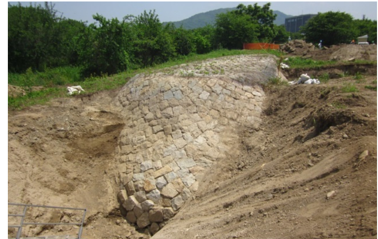
上流巻石部(亀の甲)試掘調査時の様子
