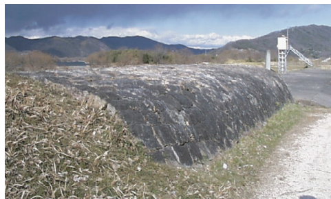
下流巻石部(亀の甲)の現状
