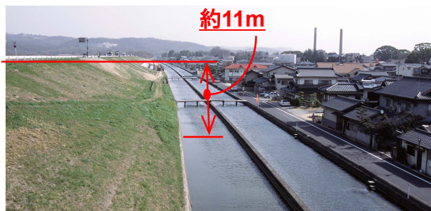
酒津地区の堤防の状況
