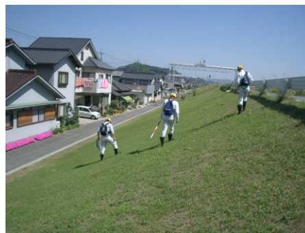
堤防点検の実施状況
