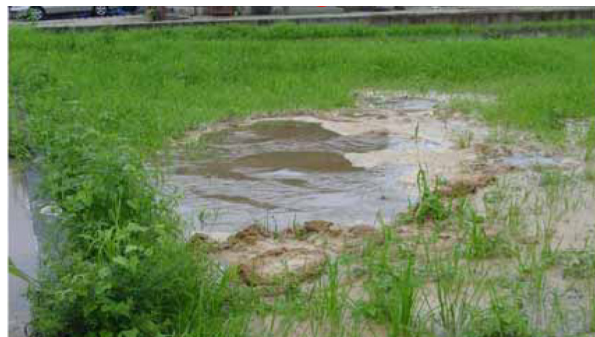
漏水に伴う噴砂の発生状況 (H18.7 洪水、総社市清音地区)
