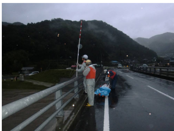
高水流量観測の実施状況
