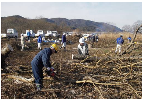
ボランティアによる樹木伐採
