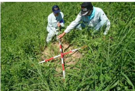
↑見つかった異状の一つ（動物が堤防を掘った跡）
