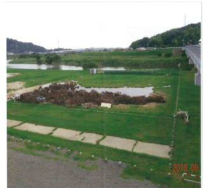
↑ 高水敷の被災状況
