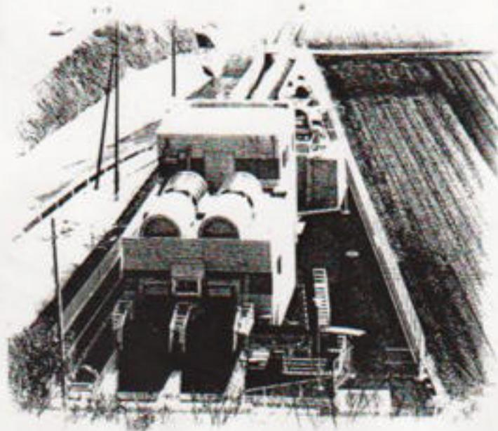
旭川の放水路である百間川が増水すると、その支川である倉安川がたびたび内水氾濫を起こし、周辺道路、民家が冠水の被害にあいます。このたび完成しました倉安川排水機場は、この被害の軽減を図るものであり、運転管理方法の機能的特徴として、中国地方で初めて、ポンプ、除塵機、樋門ゲートの運転操作や状態監視等がタッチパネル式の液晶モニター1台に集約されて行われます。
