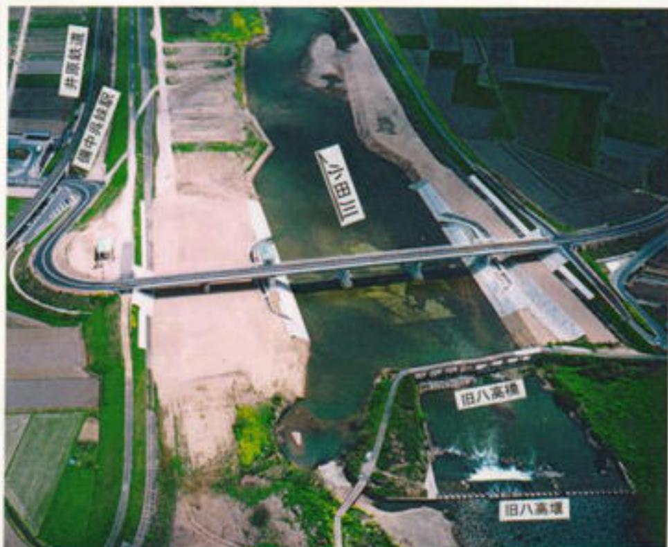
真備町の高梁川水系小田川にある八高堰はコンクリートの固定堰であり、八高橋は洪水時には水没する潜伏橋であるため、増水の時に交通止めとなるほか、流水を堰上げ、氾濫する危険性がありました。
