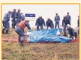
シート張り工
