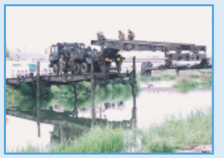
仮設橋架設訓練
