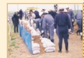
改良積土のう工
