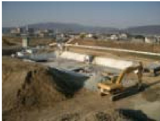
百間川新田浄化施設 工事現場写真
