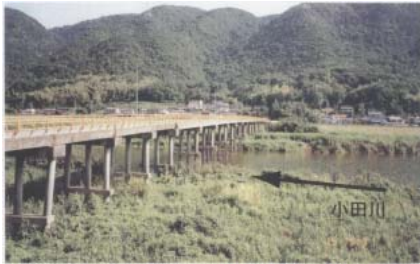
写真 - 1 井の口橋
