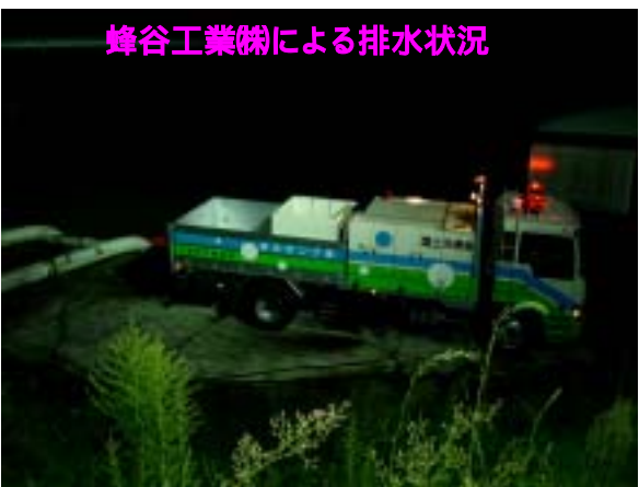
徳富地区 台風23号による排水状況
