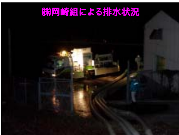
玉島地区 台風23号による排水状況
