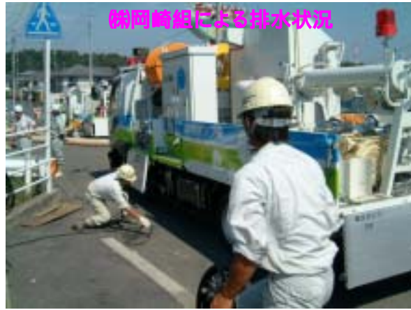
玉島地区 排水ポンプ車による稼働状況
