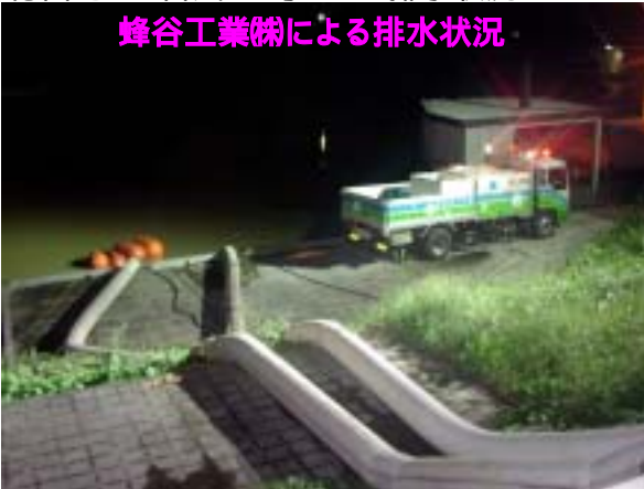
徳富地区 台風21号による排水状況
