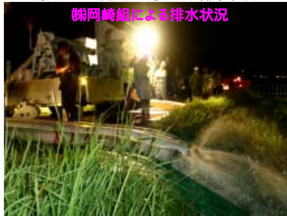
勢力地区 台風21号による排水状況
