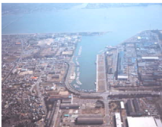
高梁川河口部(乙島地区)
