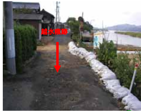
岡山市乙子 浸水状況 (H16.8 台風 16 号)
