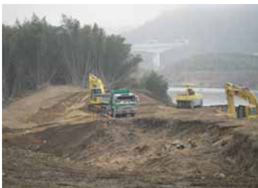
赤磐市千躰 改修状況（旧堤撤去）
