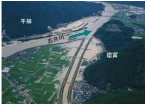
熊山町千隼 浸水状況 (現赤磐市) (H10.10 台風 10 号)
