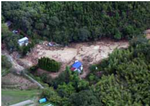
岡山市宮浦地内の土石流発生状況 (H16.9 台風 21 号)
