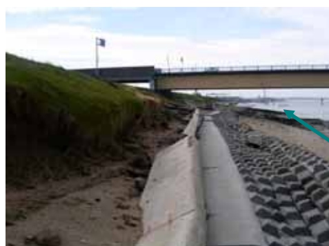
倉敷市連島町 被害状況 (H16.8 台風16号)
