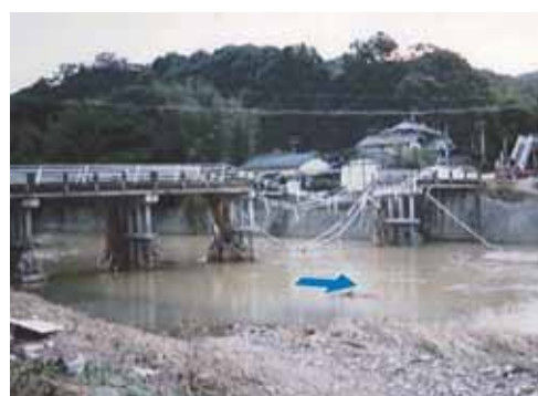
津山市平福 浸水状況 (H10.10 台風 10 号)
