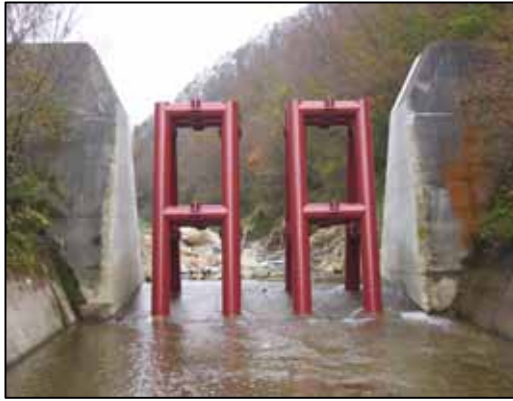
植杉谷川（真庭市）透過型えん堤
