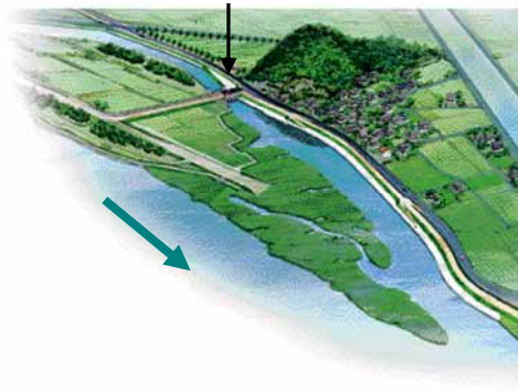
新永江川樋門
