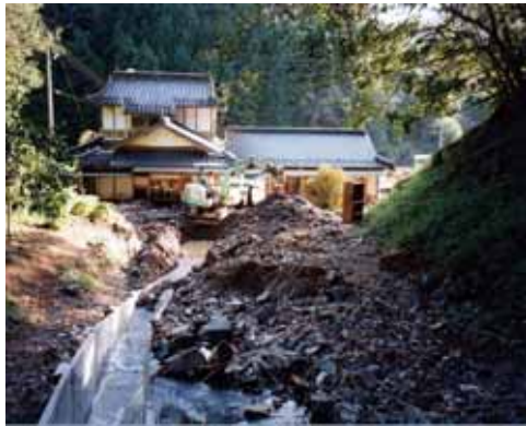
美作市尾谷 土石流発生状況 (H16.9 台風 21 号)
