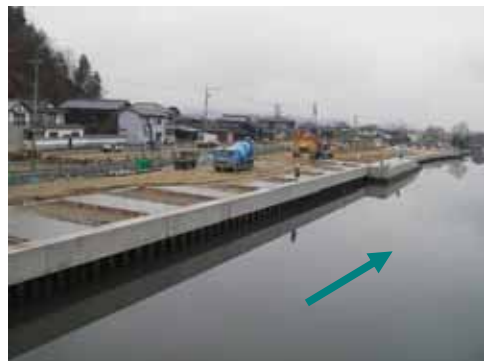
岡山市乙子 改修状況 (築堤護岸整備)
