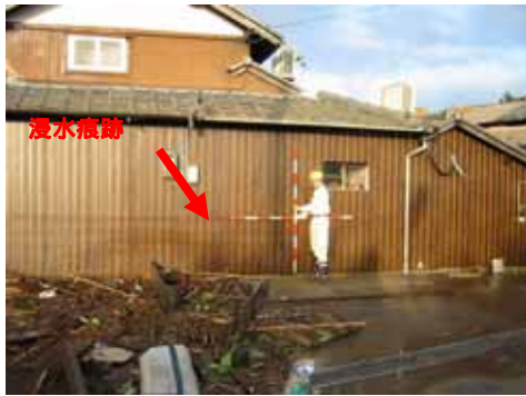
岡山市西幸西 家屋浸水痕跡 (H16.8 台風 16 号)
