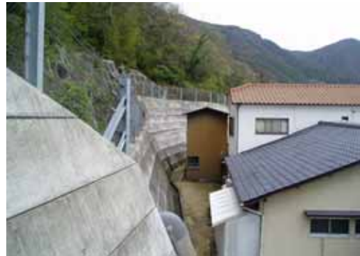
宮の鼻地区（瀬戸町）急傾斜地崩壊対策
