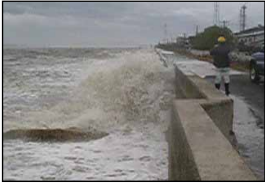
倉敷市玉島乙島 台風時越波状況 (H16.9 台風 18 号)
