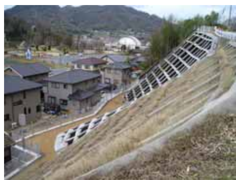
薬師上地区（笠岡市）急傾斜地崩壊対策
