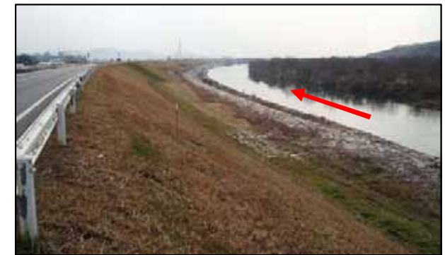
堤防強化工事 着手前状況
