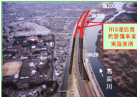
対策工の整備箇所
