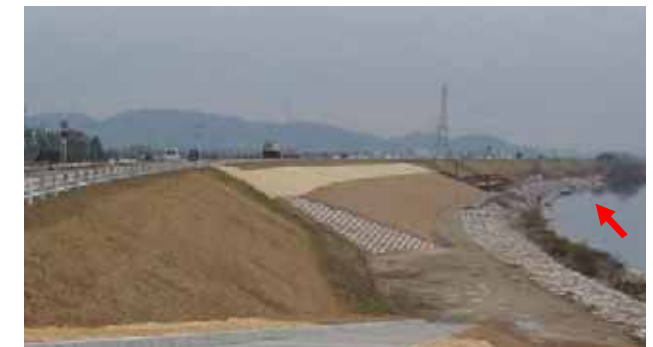
堤防強化工事 完成状況
