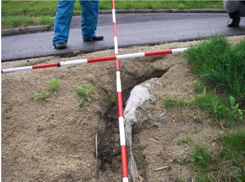
堤防法面の侵食
