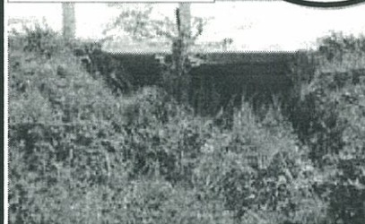
A:低水護岸端部段差
