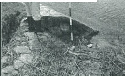
A:低水護岸端部段差
